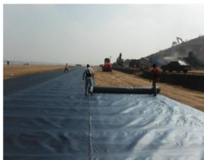
Aplicación de Geotextil tejido Tencate Mirafi Series HP, refuerzo de caminos de acceso en suelo blando, Oaxaca (2012).
