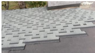
Aplicación de Teja asfáltica TN Shinglas Foxtrot Poplar en casa habitación (1), Valle de Bravo (2021).
