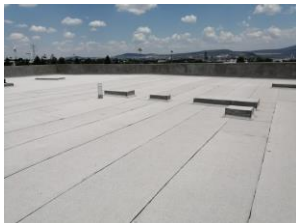
Aplicación de Membrana asfáltica Technicol Ultraplast APP FP 4.0 mm color blanco en Centro educativo (2), Querétaro (2018).
