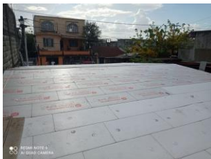
Aplicación de Aislante térmico XPS CARBON ECO en casa habitación, Ciudad de México (2021).
