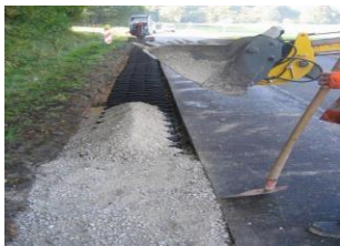
Aplicación de Geocelda GG20 para reforzar y mejorar hombros o bermas de carreteras .
