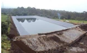
Aplicación de Geomembrana HDPE para laguna artificial de almacenamiento de agua de lluvia.
