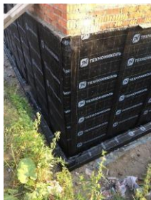
Aplicación de Membrana asfáltica autoadherible Ultraflez SA HDPE en cimentación de casa habitación (2).
