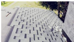
Aplicación de Teja asfáltica TN Shinglas Foxtrot Poplar en casa habitación (3), Valle de Bravo (2021).
