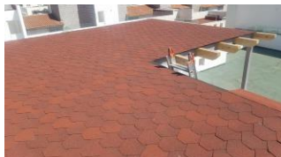
Aplicación de Teja asfáltica TN Shinglas Quadrille Hex Red en pérgola (1), Toluca (2021).
