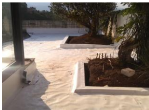
Aplicación de Geomembrana PVC 1.0 mm para impermeabilización para sistema de roof garden, Bosque de las Lomas (2020).
