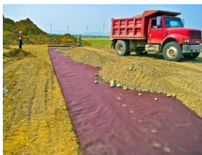
Aplicación de Geotextil tejido Tencate Mirafi Series RSi, refuerzo de caminos de acceso sobre suelo blando, Tamaulipas (2018).
