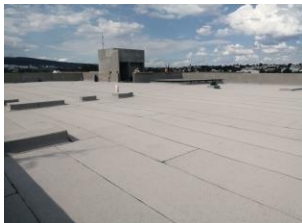
Aplicación de Membrana asfáltica Technicol Ultraplast APP FP 4.0 mm color blanco en Centro educativo (1), Querétaro (2018).
