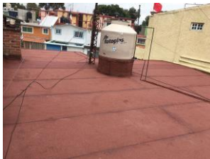
Aplicación de Membrana asfáltica Technicol Technobit APP FP 4.50 mm color rojo en casa habitación, Coyoacán (2021).
