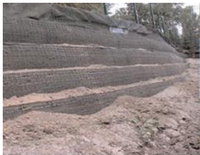
Aplicación de Geomalla Tencate Mirafi Miragrid XT para muro mecánicamente estabilizado.
