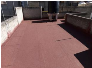
Aplicación de Membrana asfáltica Technicol Ultraplast APP FP 3.50 mm color rojo en casa habitación, GAM (2020).
