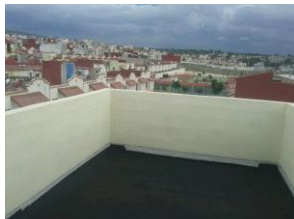
Aplicación de Geodren AWD Sitedrain Sheet 114 en azotea ajardinada, Tecamac (2014).
