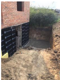
Aplicación de Membrana asfáltica autoadherible Ultraflez SA HDPE en cimentación de casa habitación (3).
