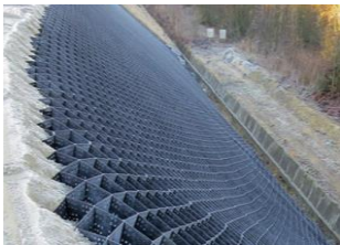
Aplicación de Geocelda GG20 para estabilizar pendientes pronunciadas.
