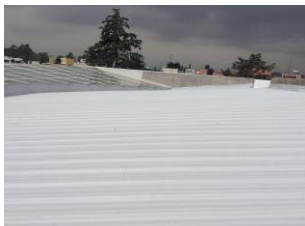
Aplicación de Geomembrana PVC-MP 1.2 mm para impermeabilización de cubierta, UAM Xochimilco (2014).
