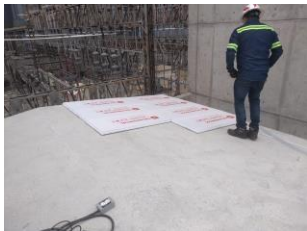
Aplicación de Aislante térmico XPS CARBON en subestación eléctrica, Ciudad de México (2021).
