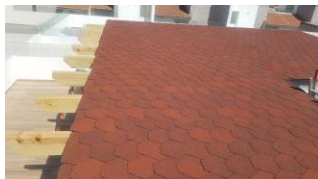
Aplicación de Teja asfáltica TN Shinglas Quadrille Hex Red en pérgola (3), Toluca (2021).
