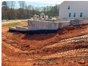
Aplicación de Geodren AWD Sitedrain Sheet 114 en cimentaciones residenciales.
