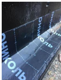
Aplicación de Membrana asfáltica autoadherible Ultraflez SA HDPE en cimentación de casa habitación (4).
