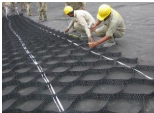
Colocación de Geocelda GG20.
