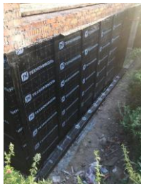
Aplicación de Membrana asfáltica autoadherible Ultraflez SA HDPE en cimentación de casa habitación (1).
