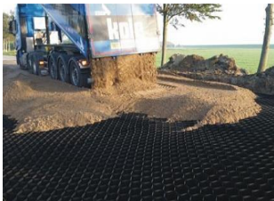
Aplicación de Geocelda GG20 para reforzar camino de acceso.
