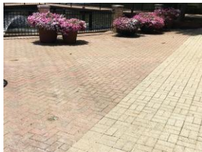
Aplicación de Geodren AWD Sitedrain Sheet 114 en patio con adoquines.
