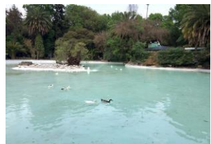
Aplicación de Geomembrana PVC Balsas 1.2 mm para impermeabilización de lago artificial, Parque México (2015).
