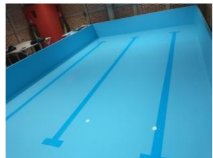
Aplicación de Geomembrana PVC Liner 1.5 mm para impermeabilización y acabado de piscina de lámina metálica, Jalisco (2021).
