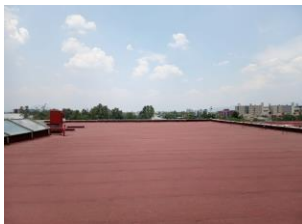
Aplicación de Membrana asfáltica Technicol Ultraplast APP FP 4.0 mm color rojo en UV, Coyoacán (2021).
