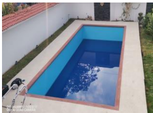
Aplicación de Geomembrana PVC Liner 1.5 mm para impermeabilización y acabado de piscina, Tuxtla Gutierrez (2021).
