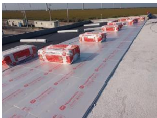
Aplicación de Aislante térmico XPS CARBON ECO en tienda departamental, Ciudad de México (2017).
