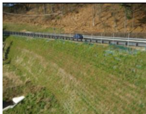
Aplicación de Geomalla Tencate Mirafi Miragrid BXG para muro mecánicamente estabilizado.
