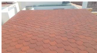
Aplicación de Teja asfáltica TN Shinglas Quadrille Hex Red en pérgola (2), Toluca (2021).
